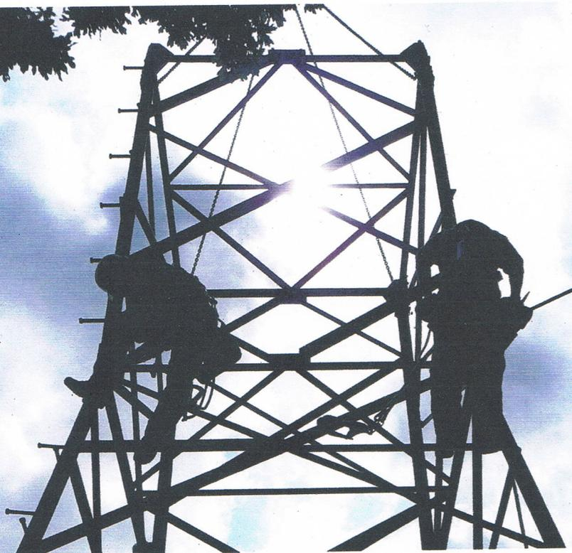
Monteure schrauben per Hand die einzelnen Mastteile zusammen.
